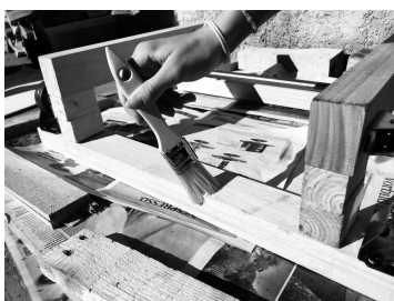
Bild 9: der Schlitten wird mit Holzschutzmittel behandelt
