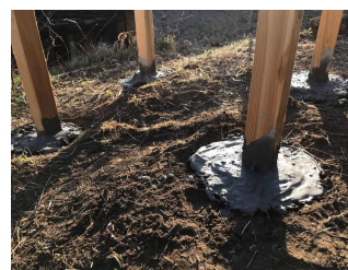
Bild 19: einbetonierte Pfosten
