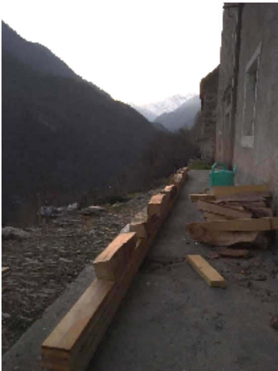
Bild 12 und 13: verleimte und imprägnierte Bretter zum Trocknen ausgelegt
