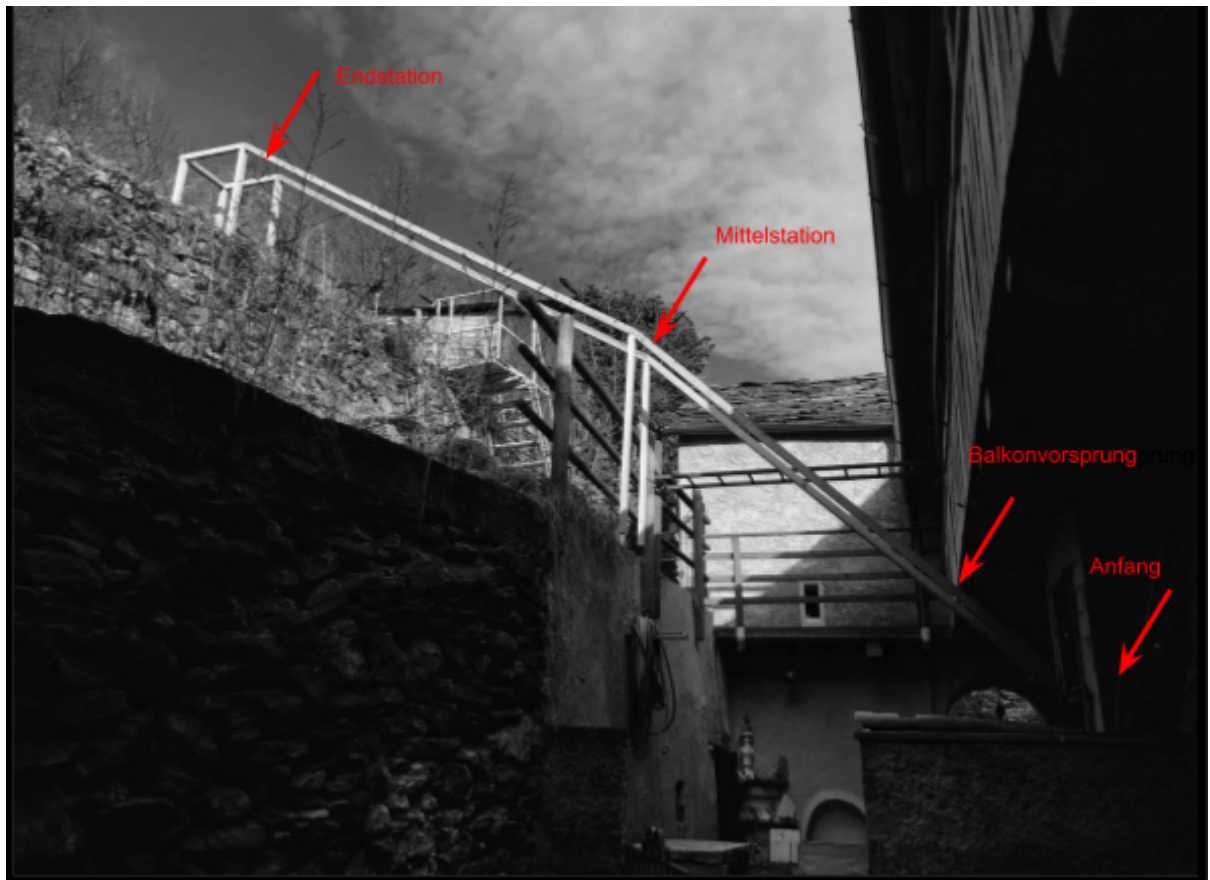
Bild 3: Situation der Hanglage
