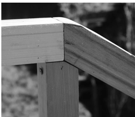
Bild 21-23: Abschrägen der Pfosten und Abrundung der Schienen
